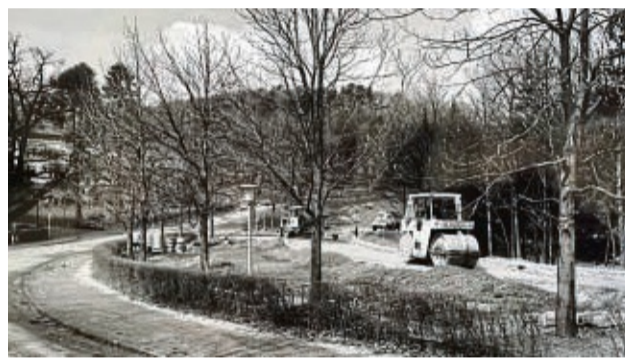
Anfang der 1970-er Jahre: Auftakt der Bauarbeiten für den Neubau; links hinter Bäumen steht das Badehotel.
